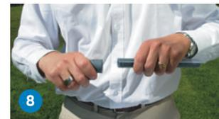
8 Saque el tubo y el accesorio de las boquillas (no lo gire) y conecte los 2 extremos calentados sin torsión.
