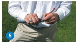
5 Marque la profundidad de la termofusión indicado en la tabla, en el tubo con el lápiz.
