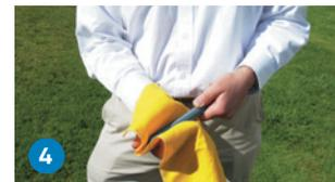
4 Limpie el extremo del tubo y el interior del accesorio a fusionar.
