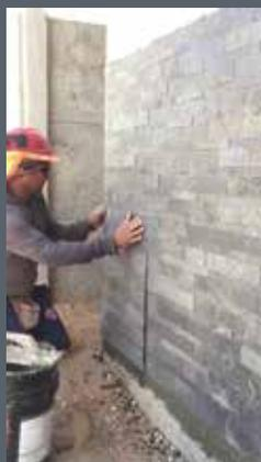
Presione con firmeza la lámina de piedra sobre el adhesivo y el muro.
