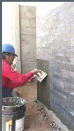
Coloque el adhesivo según la superficie en donde colocará la piedra. En la foto se muestra adhesivo cementicio, distribuyalo de manera homogénea con una llana dentada. Quite los excesos en los bordes.
