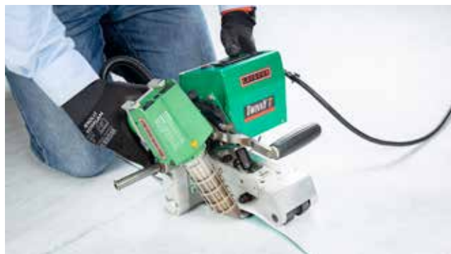
Unión mediante soldadura térmica
