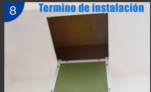
Instalación de Tapa de inspección
