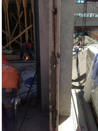
10.- Unir panel N°1 y N°2 calzando cada fierro en su perforación respectiva, generar presión para dejar una buena unión de los materiales utilizados.
