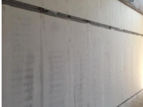
16.- En caso de conformar muchos exteriores, en las canterías de uniones de panales en cara exterior del muro deben ser aplicar un sello de Sikaflex ( o similar) para hacer las uniones impermeables.
