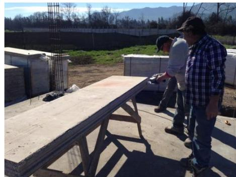
4.- Se perfora el radier en la parte de la hembra donde se hizo el cavado anteriormente descrito, con broca de 12mm introduciendo el taladro unos 15 cm., soplar el polvo para eliminar residuos que impidan una buena unión. Rellenar este espacio con adhesivo epóxico (Wurth WIT-P 200 o similar). Aplicar de adentro hacia afuera.
