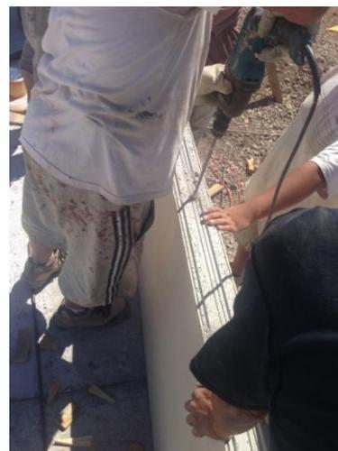
8.- En este momento tenemos el panel N°1 fijo con fierro vertical de  $\varnothing 10$  y tres fierros de  $\varnothing 8$  en forma horizontal equidistantes a lo alto y cada fierro fijado con adhesivo epóxico. El panel N°2 está con las perforaciones donde insertaran los fierros de  $\varnothing 8$ , además de haber cavado en el lado de la hembra donde se pondrá el próximo fierro de  $\varnothing 10$ .
