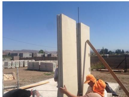
11.-Se producirá una cantería en la unión de los paneles la cual es normal, dejar esta cantería sin recubrir y no hacer nada con ella hasta terminar la obra gruesa y techumbre 100%.
