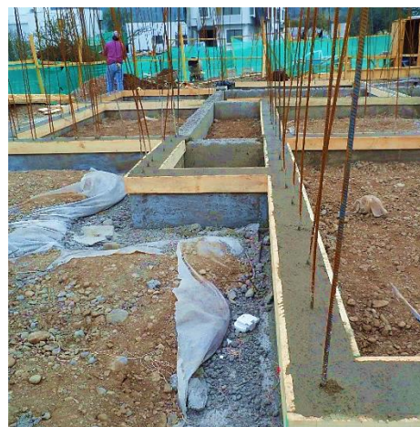
Anclaje de tensor a fundación
