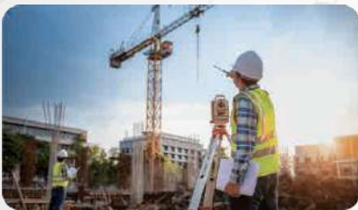
Sitios de Construcción
