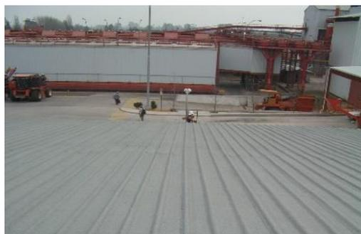
**CUBIERTA PLANA NO TRANSITABLE REFLECTANTE**
