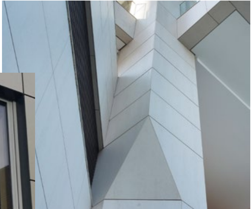
Edificio Cap Ferrat Río de Janeiro, Brasil
