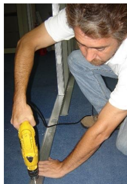
INSTALAR PERFIL INFERIOR
