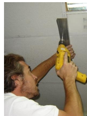
INSTALAR PERFIL SUPERIOR
