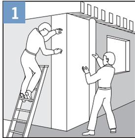
1 Comenzando a 30 cm de una esquina, desenrollar Tyvek® y continuar hasta envolver completamente la pared de la casa.
