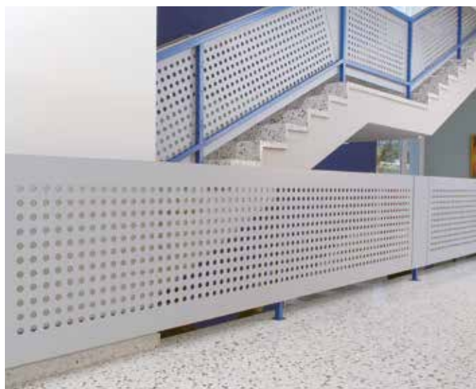
BARANDILLA DE LA ESCALERA - FRESADO DEL AGUJERO
