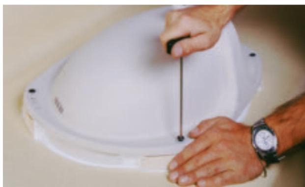
3. Pegue el lavabo con adhesivo de poliuretano y sujételo con tornillos.
