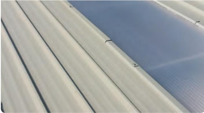
GP Coverttech es una lucarna plana de policarbonato alveolar con estructura en doble X. Se fabrican en espesores de 25mm, 30mm y 40mm, con un ancho de 1000mm.
