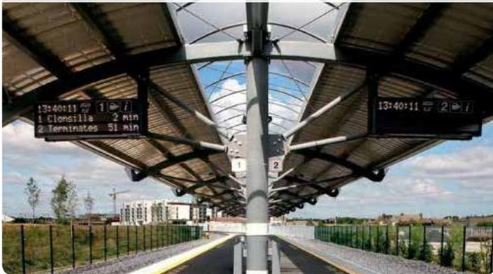
**POLICARBONATO COMPACTO**, una lámina de policarbonato plana extruida transparente que proporciona una resistencia al impacto 200 veces mayor que el vidrio, con tan solo la mitad de peso, lo que suministra protección contra roturas, soporta con facilidad un golpe de martillo, de ahí que sea sumamente apropiada para utilizar en aplicaciones de acristalamiento de seguridad, en zonas proclives al vandalismo o en aplicaciones que requieren resistencia y protecciones mejoradas.
