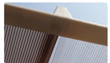
Verifique la distancia entre apoyos e instale el perfil de remate lateral de aluminio con tornillo.
