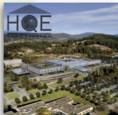
^ HOSPITAL ALES Instalación de ducha / Protección mural SPM FRANCIA
