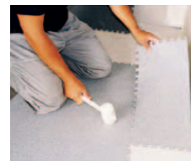
Lamas Clic System Attraction, GTI... > losetas y lamás únicas autoportantes, sin adhesivos.
